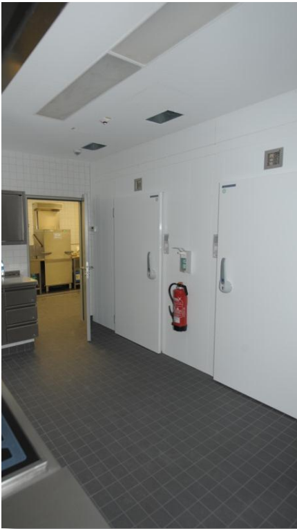
ZUGANG KÜHLRÄUME UND DURCHGANG ZUR SPÜLKÜCHE
